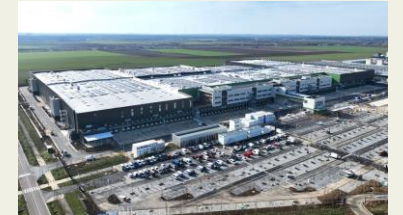
Entrepôt Zalando , Montereau-sur-le-Jard (77)
